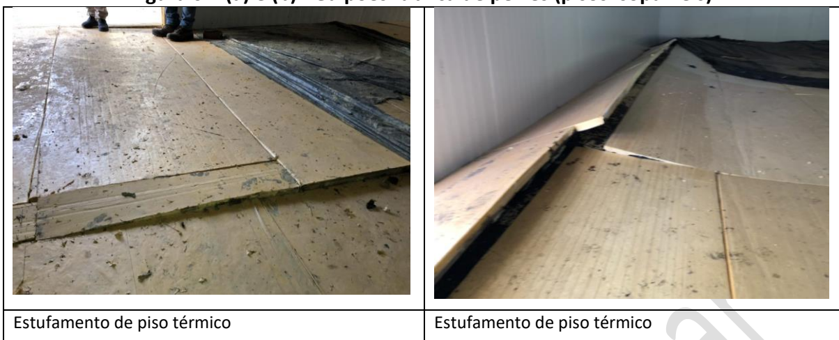
Figura 02 (a) e (b)– Galpões fábrica de peixes (pisos isopainéis).
